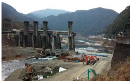
撤去工事が進む荒瀬ダム 2015.1.11
