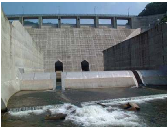
益田川ダム(島根県)を下流から見た写真
