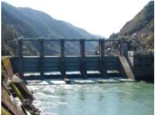
ゲート全開時の瀬戸石ダム
