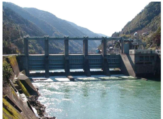
荒瀬ダム上流にある瀬戸石ダム
