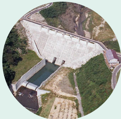
島根県益田川ダム（流水型ダム）
