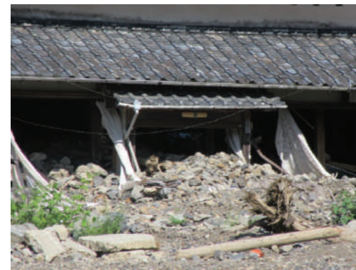
支流の災害は山から始まり 命を脅かす氾濫が発生
