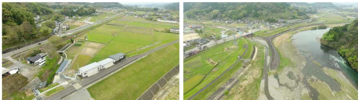
導流堤を作っても、小川には莫大な土石が堆積
