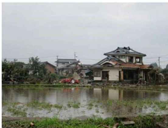
大柿地区に大洪水が流れ込んだのはダム化した第四橋梁が崩壊し大洪水を発生させたためである
