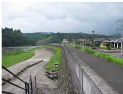
緊急放流で被害を被った虎居地区 住民と川を遮断する巨大連続堤防を 建設した
