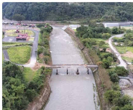
2022年台風の時の頭地橋の様子
