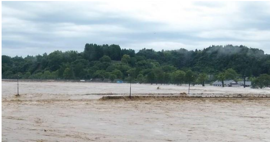
2020年7月4日 人吉市の大橋 ここに危機管理型水位計を設置
