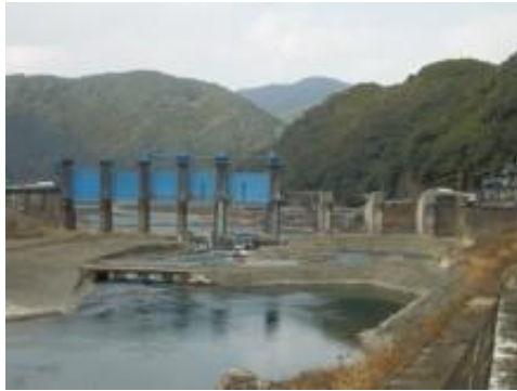
撤去中の荒瀬ダム
