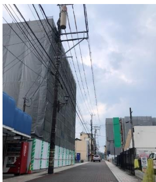
建設中の災害公営住宅 2024年8月15日撮影
