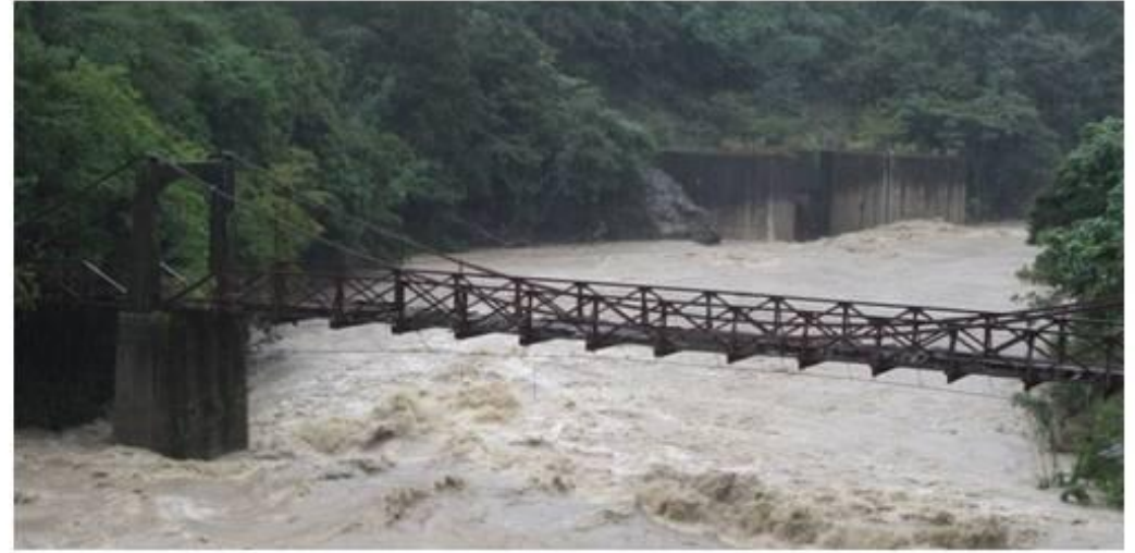
藤田の吊り橋
