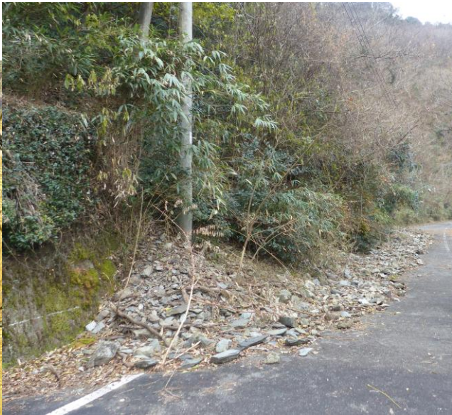
瀬目トンネル直下の様子
