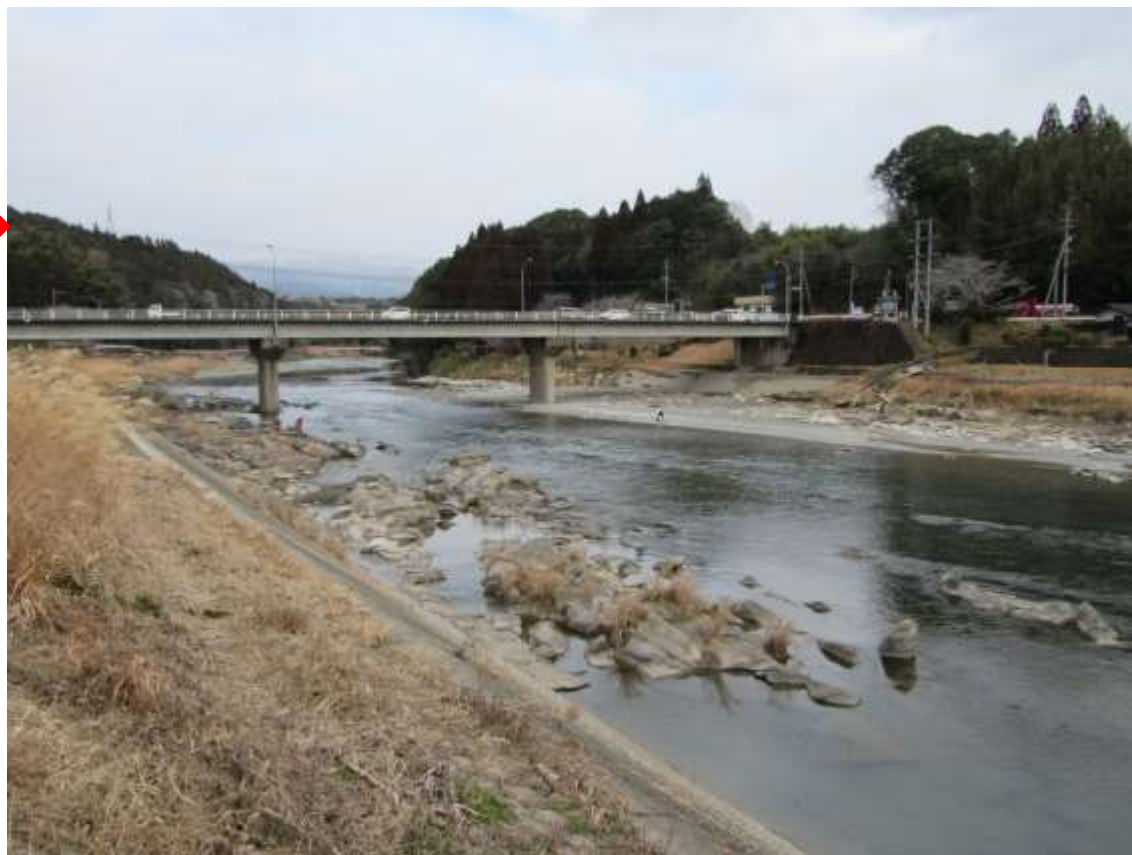
川辺川 柳瀬橋
