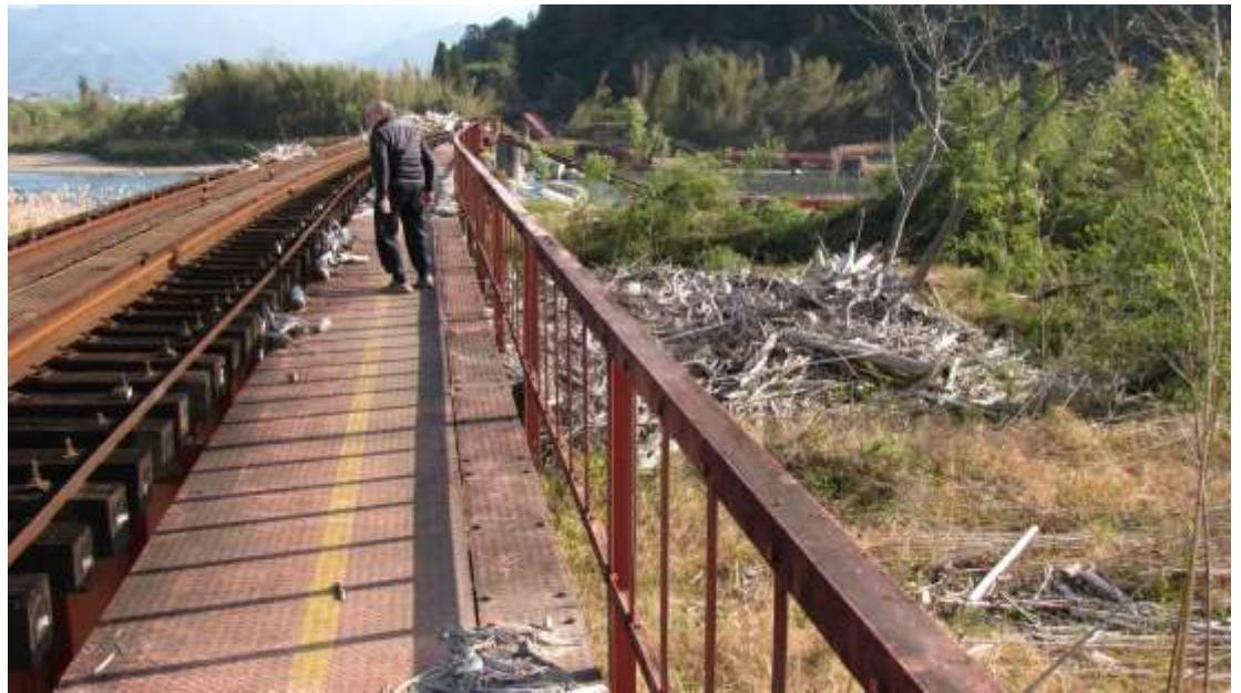
くまがわ鉄道第四橋梁 合流点の鉄橋
