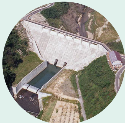
島根県益田川ダム（流水型ダム）
